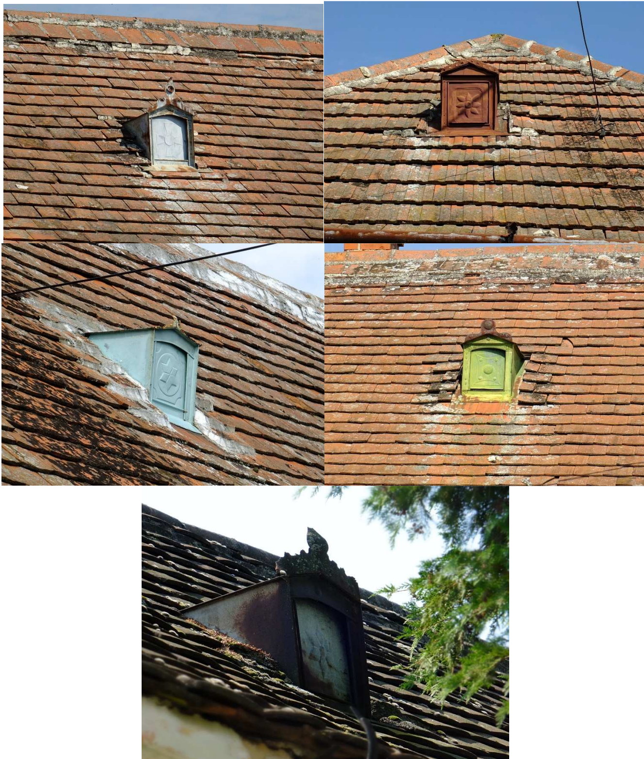
Példa bádogos tetőszellőző kialakítására.
